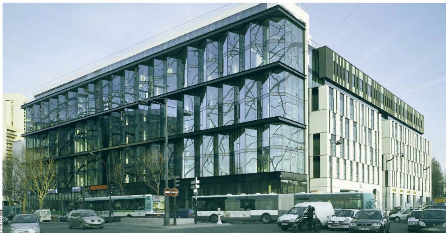
Le bâtiment de bureaux HQE Cinetic, signé par les architectes Valode et Pistre pour Cogedim/Sogeprom/Adim, récemment livré à Paris, porte des Lilas.
